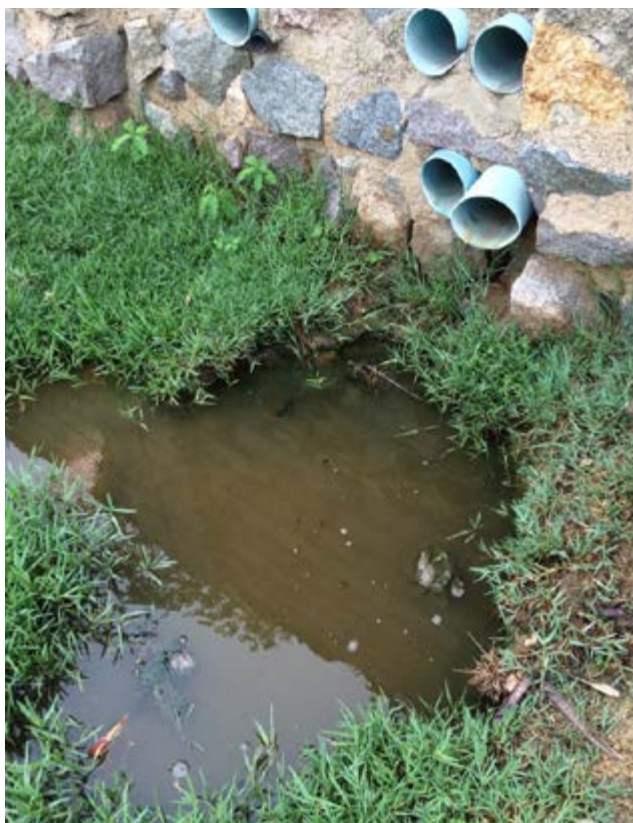
Tuyaux intégrés dans le mur d'enceinte extérieure de la station de traitement d'effluents dangereux de Ramky, à Hyderabad, déversant de l'eau qui s'accumule.
